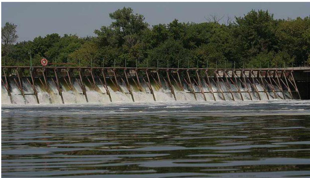
Рисунок 1 - Низконапорная щитовая плотина на р. Северский Донец
